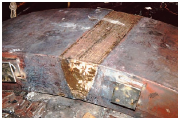
Сварка бандажа клинкерной печи
