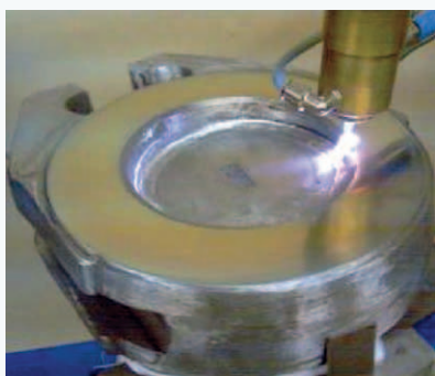
Рис. 8. Процесс нанесения нанопокрывания методом ФПУ на клин из стали 30X13 задвижки ЗКЛ2 150-250 (ОАО «Благовещенский арматурный завод»)
